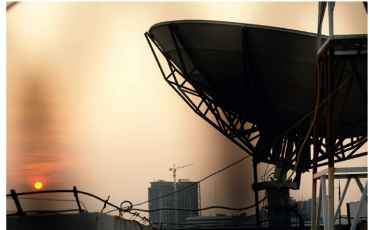
Die Antenne mit 4,5 m Durchmesser auf dem Dach des Warnzentrums empfängt die Daten aus den Sensornetzwerken in Echtzeit.
