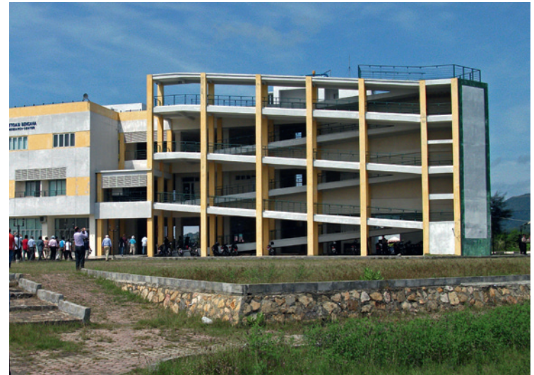
Eigens errichtete Evakuierungsplattform (Shelter) in Aceh.
